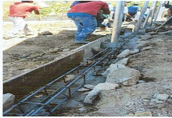
Foto 2: Instalación de hierro para cerramiento perimetral
